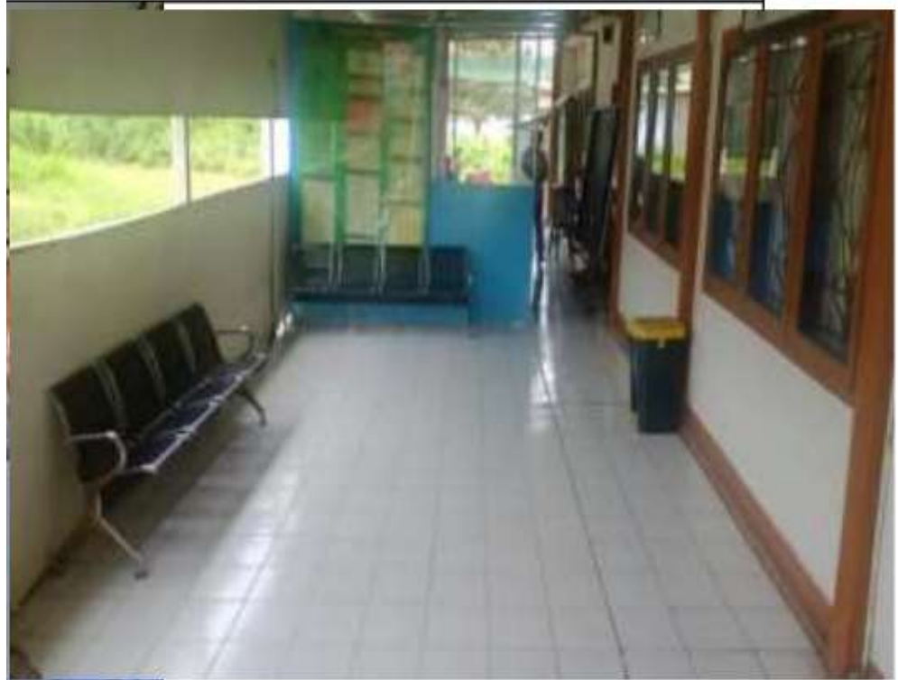
Foto 6 : Ruang Tunggu Sidang sebelum diperbaiki
