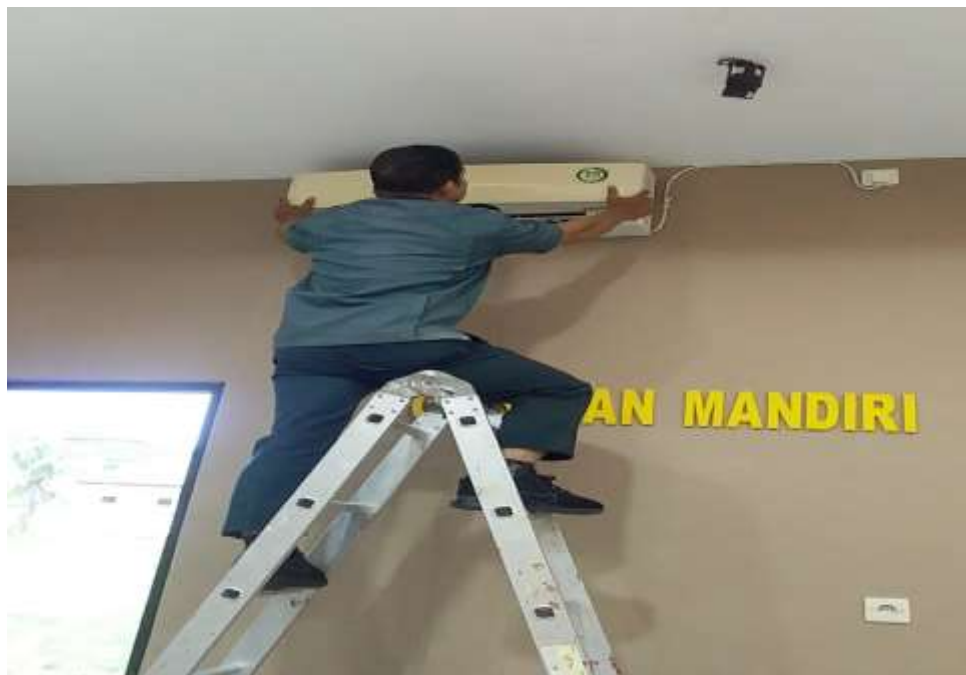
Foto 3 : Perbaikan AC di Ruang PTSP
